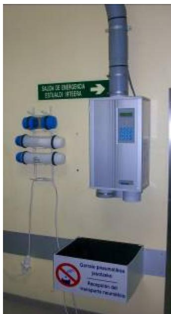
Sistemas utilizados para propulsar contenedores cilíndricos a través de una red de tubos utilizando aire comprimido.
